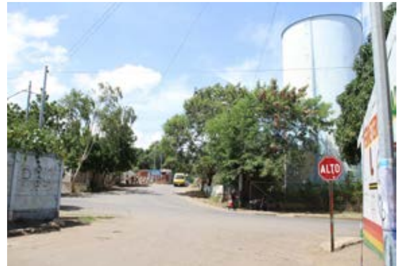
Tanque del servicio de agua potable, colonia 14 de Septiembre.
